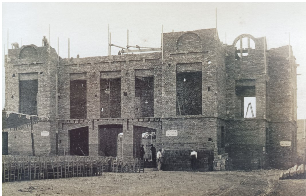
Imatges del procés constructiu
